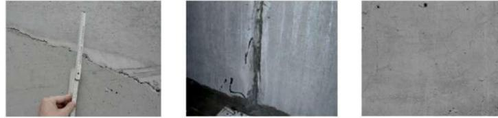
Если подвал уже залит, нужно убрать воду и найти щели и отверстия, через которые поступает вода. С помощью заглушающего цемента FIX-10S, схватывающегося непосредственно после контакта с водой, мгновенно останавливается водоприток и гидроизолируются места локальных протечек. Теперь в подвале не сыро, а просто влажно, и можно начать обследование и обработку стен.
