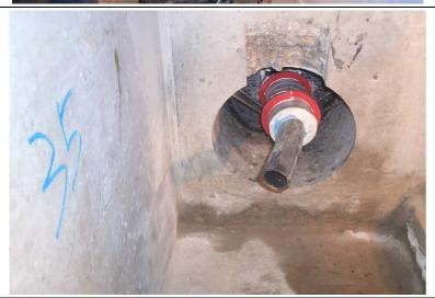
Установка проходной гильзы, набухающего профиля (места заливки текучего безусадочного ремонтного состава)
