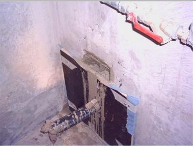
Установка опалубки и заливка текучего безусадочного состава
