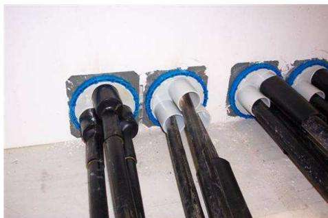
KD – система состоит из герметизирующей прокладки, которая выполнена как одинарный или двойной уплотнитель и монтируется рамками, имеющимися у уплотнительной прокладки к коробке и может быть забетонирована в опалубку. Крепление осуществляется штифтовыми гвоздями, отверстия для гвоздей – типовые. Для того чтобы избежать образования пустот, кабельный проход должен быть полностью окружен бетоном.
