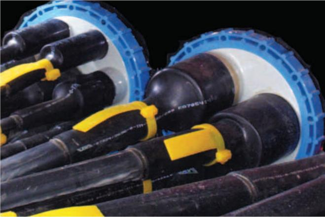
Die Bajonett-Dichtpackungen werden vor der Kabelverlegung mit den Bajonett-Systemdeckeln konfektioniert. Nach der Kabelverlegung erfolgt die Kabelabdichtung mittels Warmschrumpfmuffen. Auch die Kaltschrumpftechnik ist möglich.
