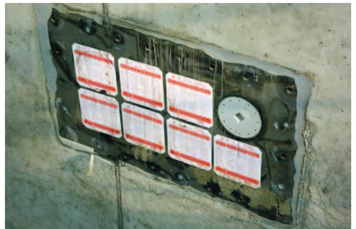
Nach dem Einbetonieren sind die Bajonett-Kabeldurchführungen BKD 150 durch die im Lieferumfang enthaltenen Blinddeckel druckwasserdicht verschlossen (Foto rechts). Auch die Futterrohre aus Edelstahl sind jetzt für die weiteren Arbeiten zur Wandabdichtung mittels Heiß-Bitumen-Bahnen vorbereitet (Foto links).
