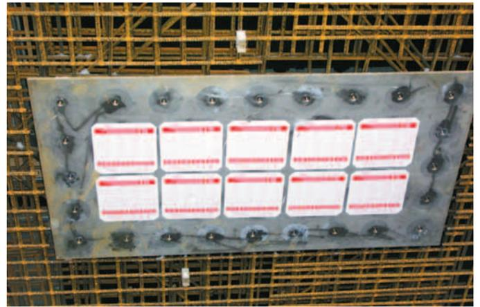
Bereits in der Rohbauphase werden spezielle Futterrohre aus Edelstahl mit integrierter Fest-Losflanschkonstruktion (Foto links) sowie Kabeldurchführungsplatten BKD (Foto rechts) ebenfalls mit Fest-Losflanschkonstruktion an der Verschalung befestigt und in der Bewehrung der Stahlbetonwände mit eingebunden.
