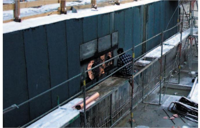
Fachkräfte der Abdichtungsfirma binden die rohbauseitigen Einbauteile in die bituminöse Abdichtung ein, verstärken die Ränder der Durchführungen mit Kupfer-Folie und verpressen die Losflansche.
