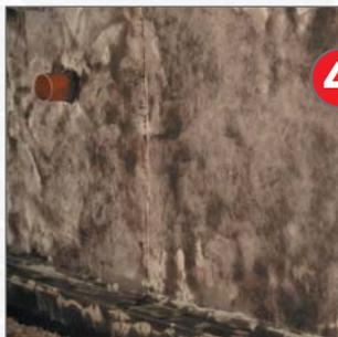
**4** В области с нагрузкой воды под давлением, если гидроизоляция должна быть изготовлена согласно DIN 18195, вмонтировать усиливающую прокладку между слоями. Для надежной защиты гидроизоляционного слоя на свежее KMB укладывается **ASO®-Systemvlies-02** и равномерно прижимается гладилкой.
